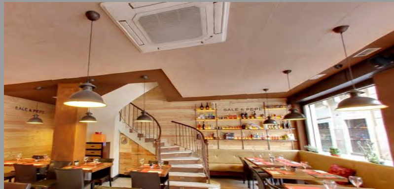
Panneaux acoustiques au plafond
